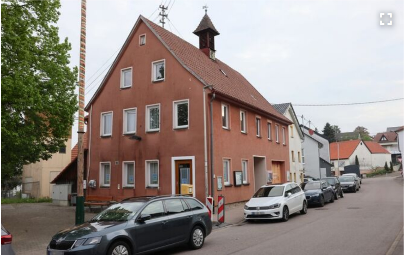
Das Alte Rathaus in Breuningsweiler. Die Sanierungsarbeiten sollen im Juli beginnen. © Gabriel Habermann
